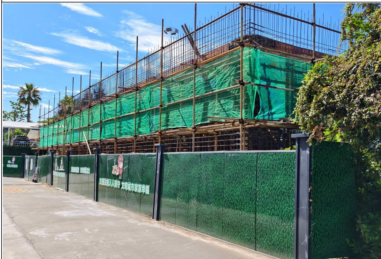
消防水池和泵房场地现状
